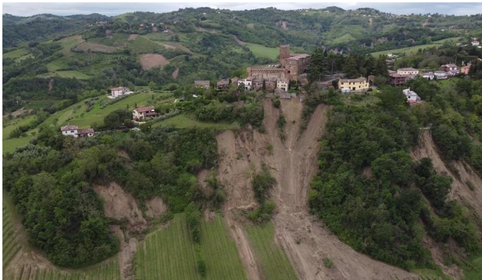
Figura 73 - Esempio di colate in terra presso Roncofreddo (FC). Sono visibili decine di punti di innesco, tra il versante in primo piano e quelli in secondo. Fonte: Regione Emilia-Romagna
