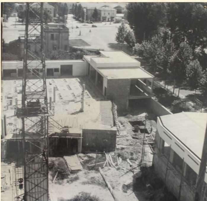
Nelle foto dei lavori di costruzione della caserma si vede chiaramente quale fosse all'epoca l'altezza del terreno, la stessa quota che attualmente ricopre i pavimenti dell'interrato. L'edificio, infatti mostra i pilasti portanti fuori terra e gli attuali cortili come piano sopraelevato.
