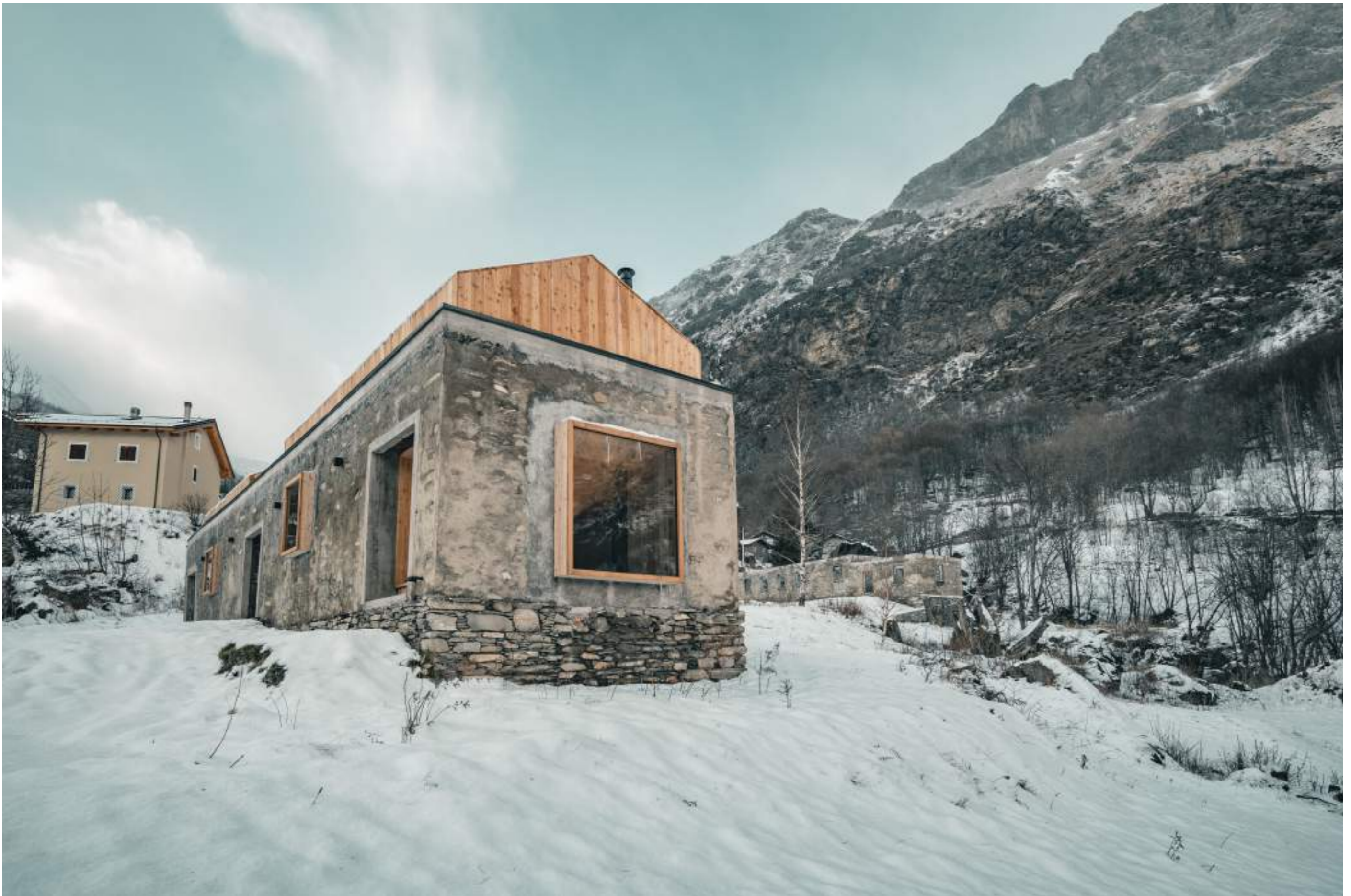
Bando "Architettura minima nelle Alpi" - Sezione I - Architettura minima per le comunità
